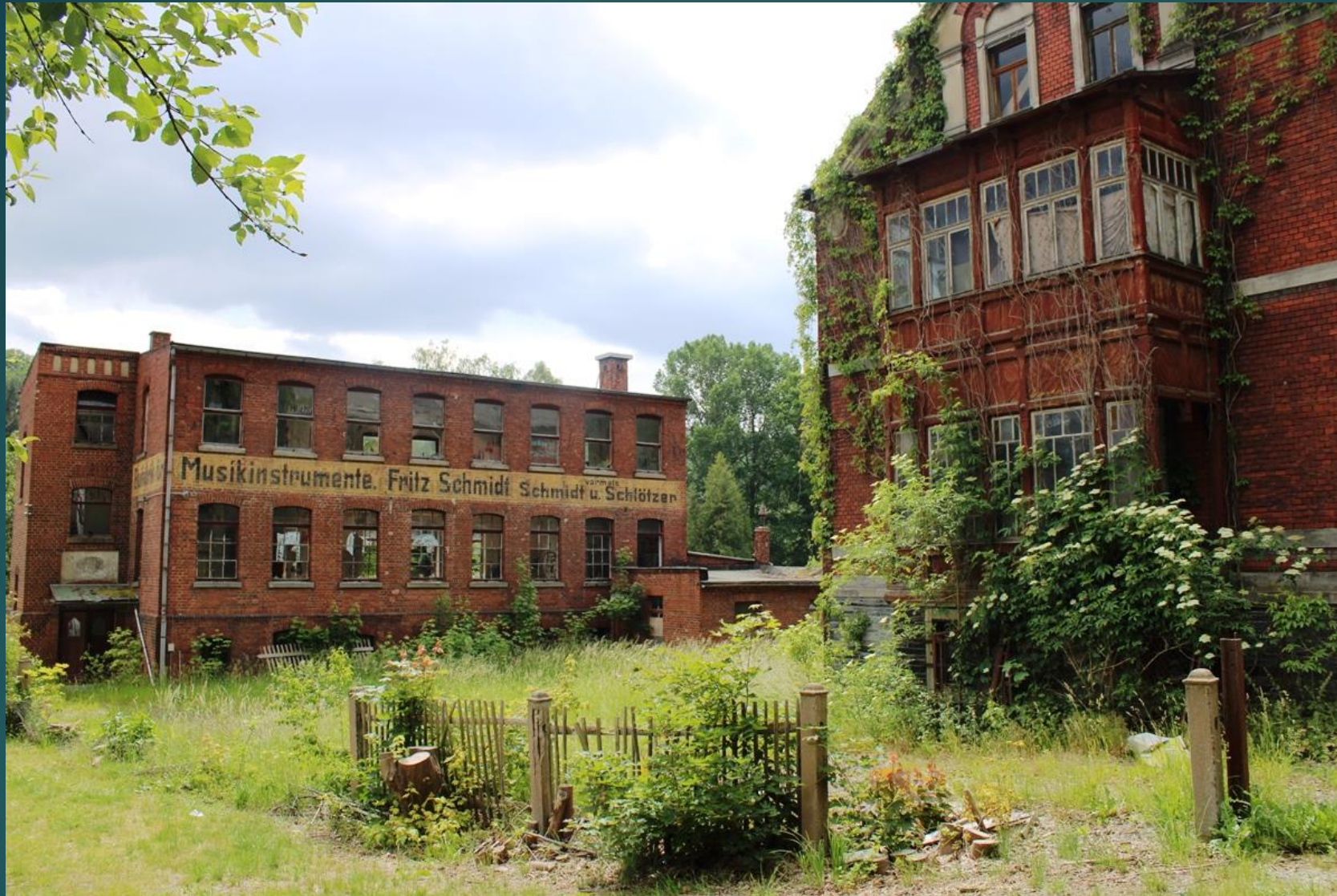
ehem. Produktionsstätte E. Krause Perlmutterwarenfabrik Adorf i. Vogtl
